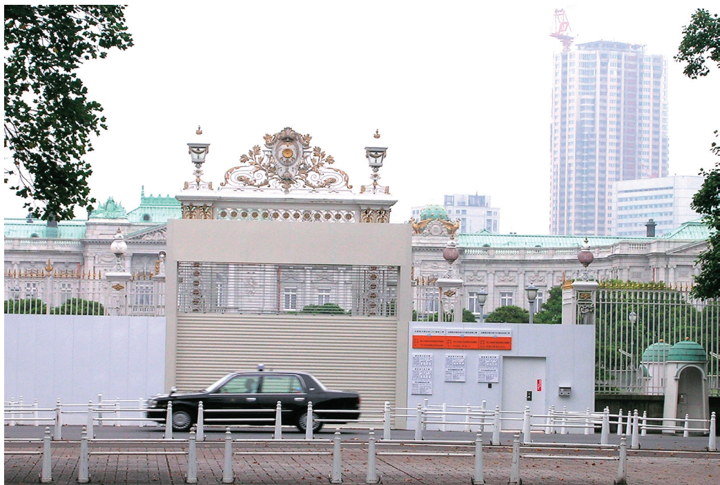
工事中の迎賓館正面
