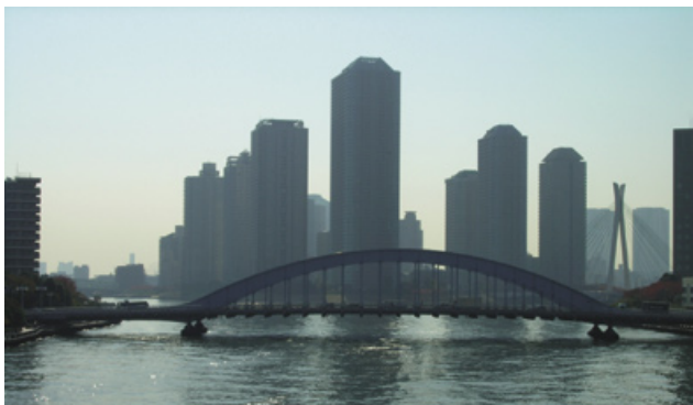
「リバーシティ21」と永代橋
