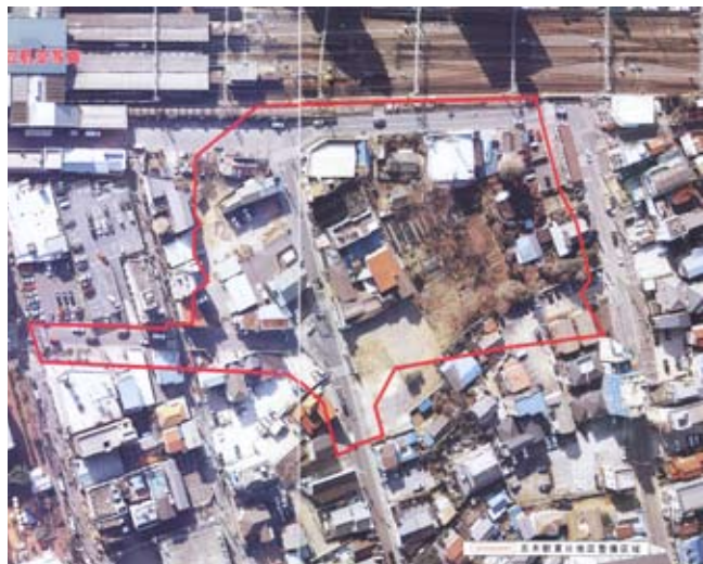
着工直前の事業区域（平成八年十二月撮影） 志木市と新座市との境界に在って、多くの懸案を抱えたまま、長期間に亘ってスタートできなかった駅前再開発が着工した。
